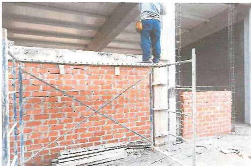
FOTO N°14: encofrado de columnetas/viguetas tercer nivel modulo II
