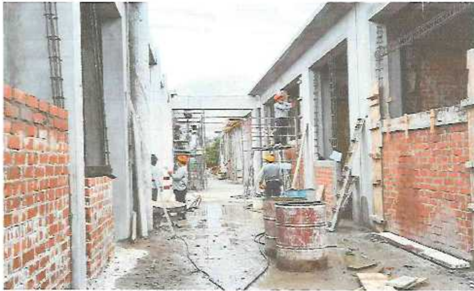
FOTO N°11: Encofrado de columnetas/viguetas en tercer nivel modulo II
