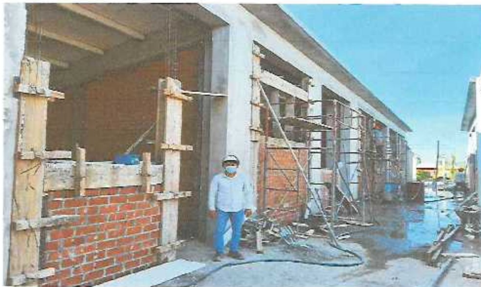
FOTO N°15: encofrado de columnetas/viguetas tercer nivel modulo II
