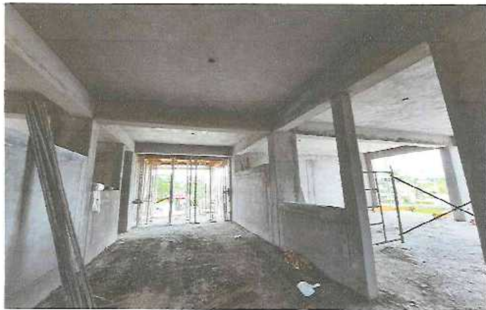
FOTO N°04: Culminado de tarrajeo de muros/columnas y vigas segundo nivel modulo I
