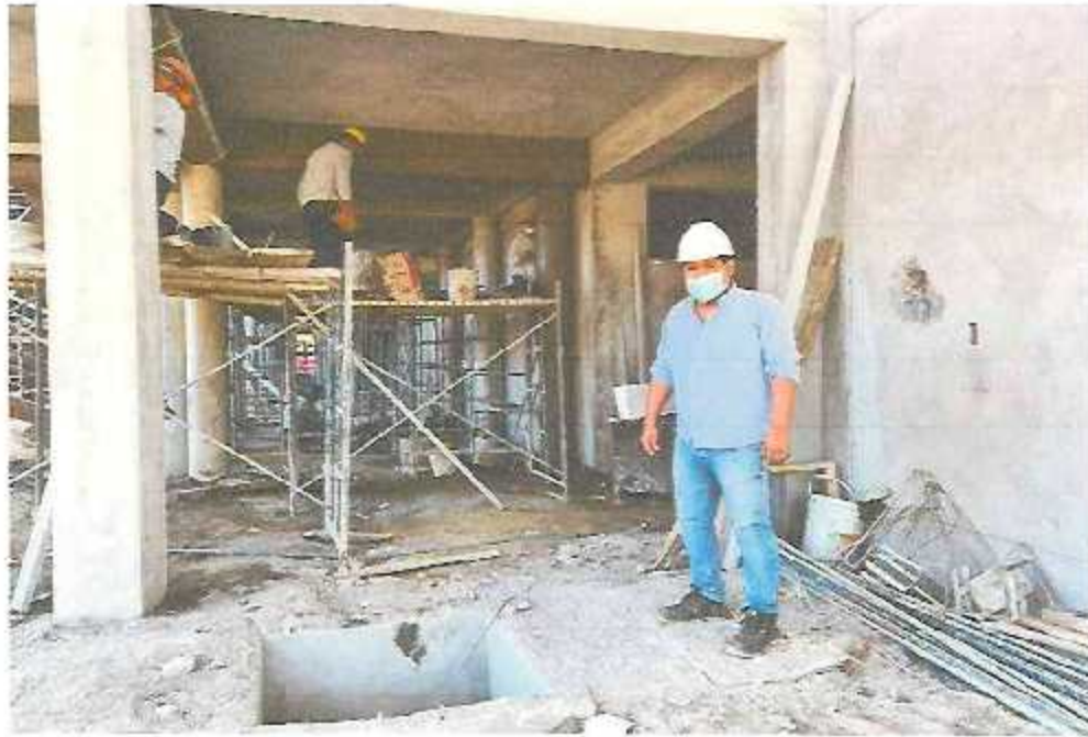
FOTO N°03: tarrajeo de columnas y vigas en primer/segundo nivel modulo I
