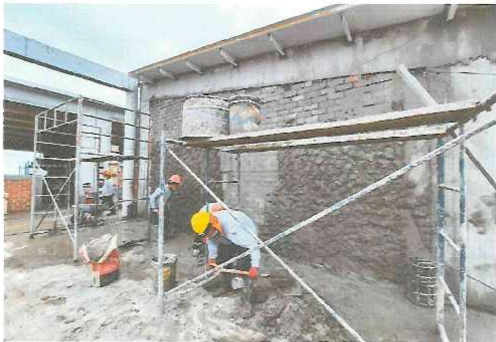
FOTO N°10: Tarrajeo de muro tercer nivel modulo II
