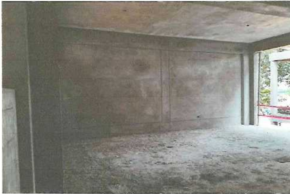
FOTO N°19: Culminado de tarrajeo de muros/columnas y vigas segundo nivel modulo IV
