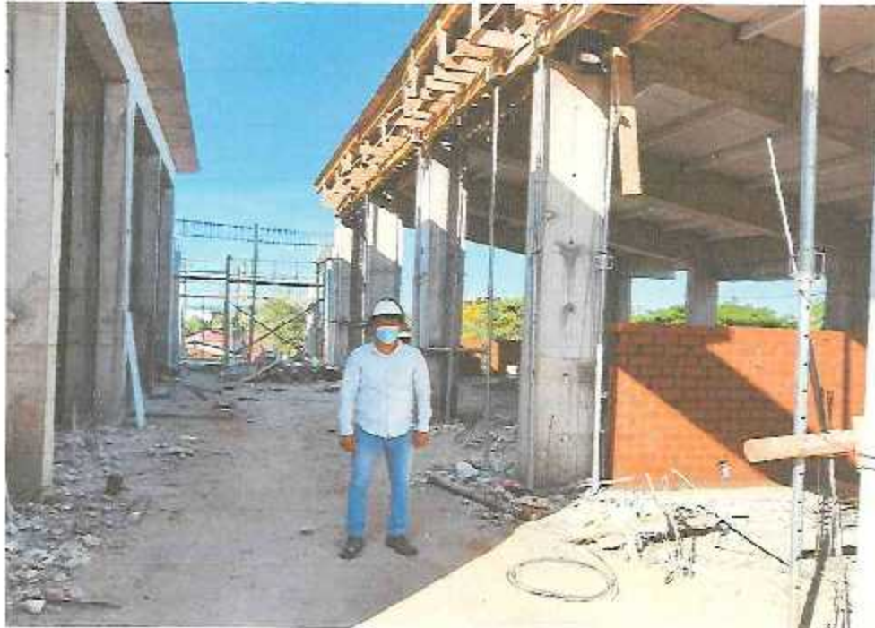
FOTO N°08: Asentado de muros Y colocación del panel termoacústico en tercer nivel modulo I
