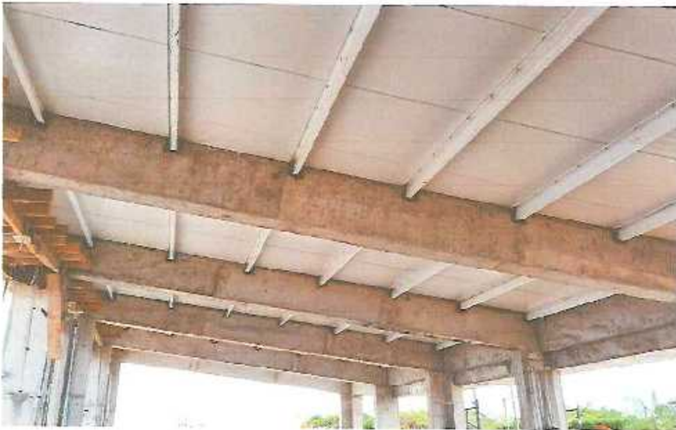
FOTO N°06: Culminación del colocado del panel termoacústico tercer nivel modulo I
