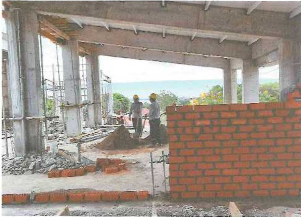
FOTO N°05: Asentado de muros en tercer nivel modulo I
