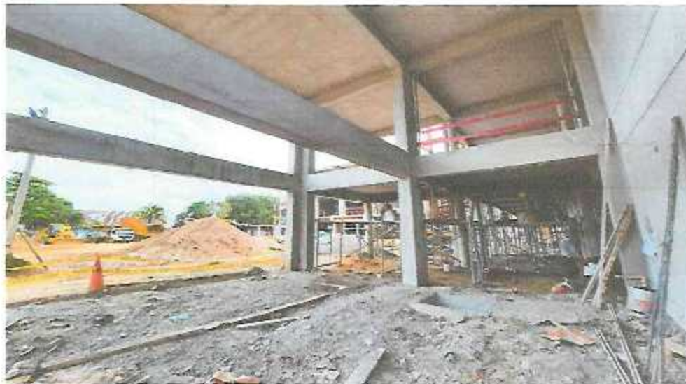
FOTO N°02: Culinado de tarrajeo de columnas y vigas en primer/segundo nivel modulo I
