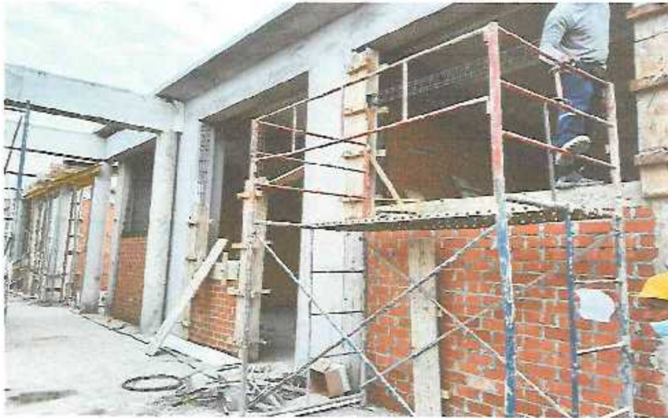
FOTO N°17: encofrado de columnetas/viguetas tercer nivel modulo III
