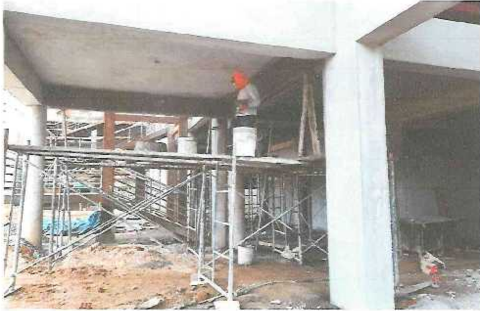
FOTO N°01: Tarrajeo de columnas y vigas primer nivel modulo I
