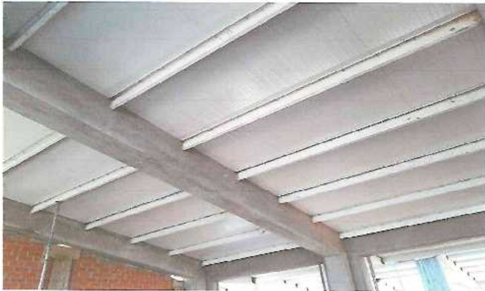
FOTO N°18: colocación del panel termoacústico tercer nivel modulo III.
