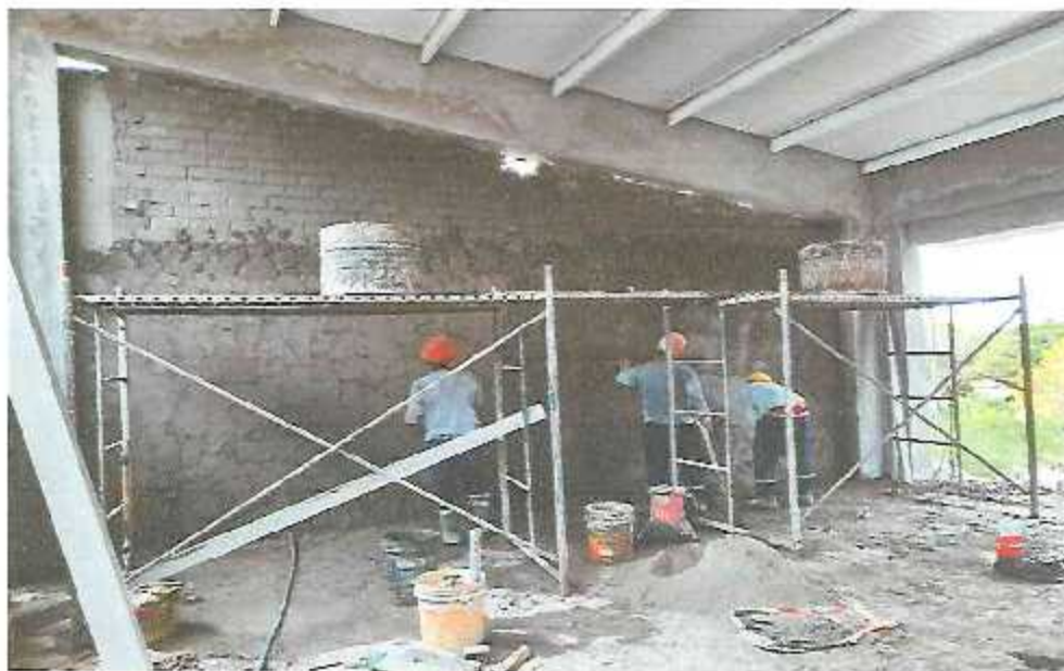
FOTO N°13: tarrajeo de muro en tercer nivel modulo II
