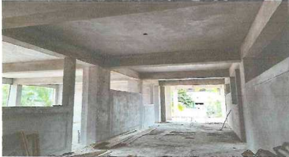
FOTO N°09: Culminado de tarrajeo de muros/columnas y vigas segundo nivel modulo II
