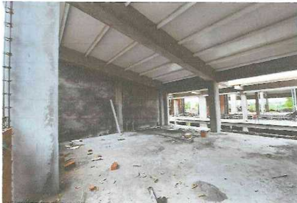
FOTO N°12: Culminación del tarrajeo de muro y colocación del panel termoacústico tercer nivel modulo II.
