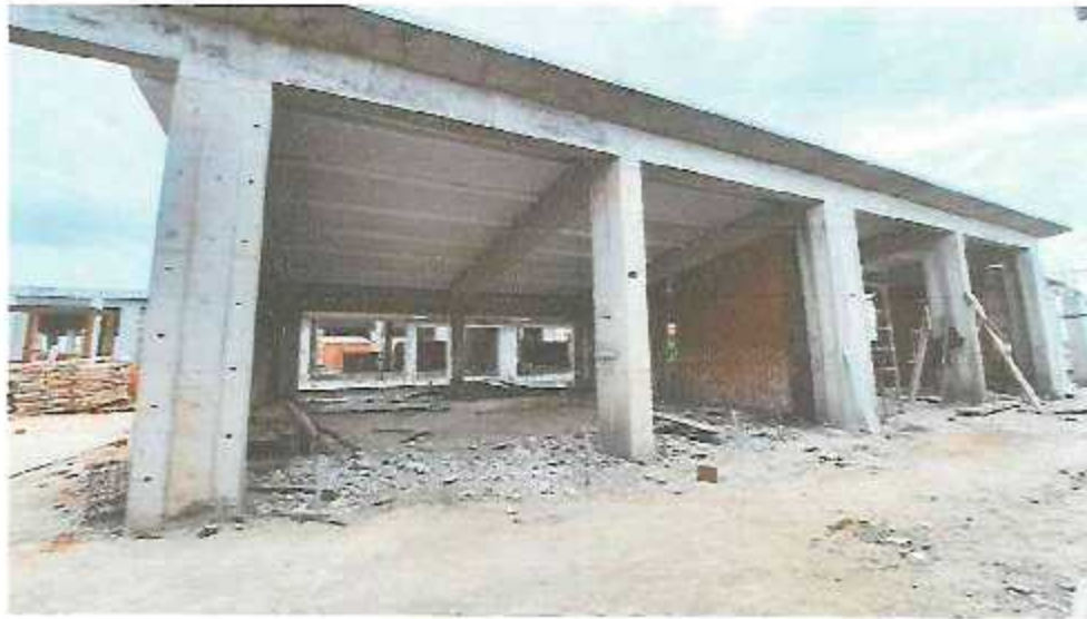
FOTO N°07: Culminación del asentado de muro y colocación del panel termoacústico tercer nivel modulo I.
